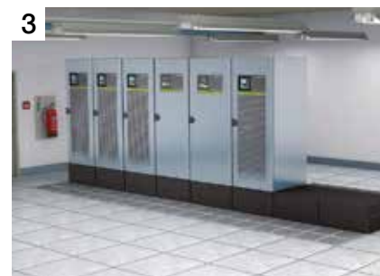
3 30 minutos después: 800 kW, modo online de doble conversión
